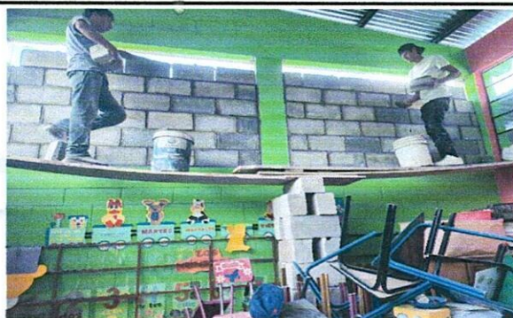
Foto 5: mejoramiento de ventanas aula 3 y 4
