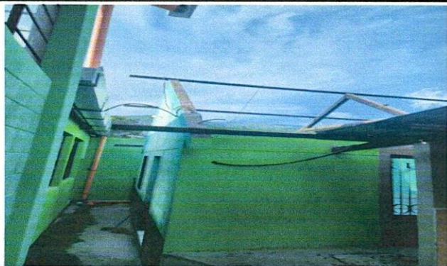
Foto 1: Mejoramiento de techo, bodega, baños y patio
